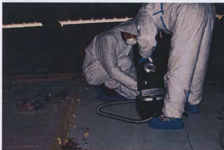
Bilde nr. 5. Bildet viser montering av støvsuger.
