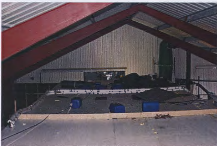
Bilde nr. 4. Bildet viser deler av «loftet» i produksjonslokalet til Raunes Fiskefarm. Det område som er lengst bort (med blåe kanner) er et av flere områder som ble støvsuget. Bildet er tatt fra den møneveggen som vender mot AF Decom sitt anlegg.
