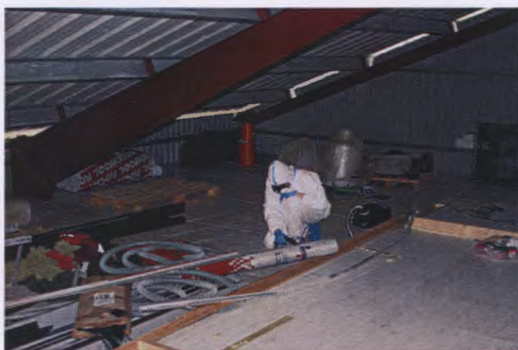
Bilde nr. 10. Bildet viser fortsatt innsamling. I mønet og langs veggen ser vi åpningene (spalter) hvor det er luftinnstrømning til lokalet.
